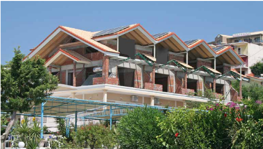
vorher: Rohbau eines Apartmenthotels
